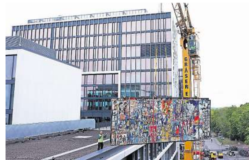
Das größte Bild Deutschlands wiegt 2000 Kilogramm. Diese Last musste der Kran über das Dach des Karlsruher Hauptbahnhofs heben. FOTOS: MERAL ALMA
