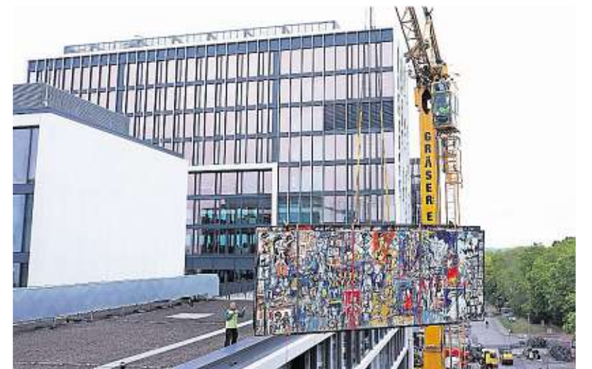
Das größte Bild Deutschlands wiegt 2000 Kilogramm. Diese Last musste der Kran über das Dach des Karlsruher Hauptbahnhofs heben.
